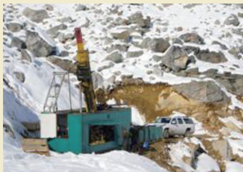
ラドッククリークボーリング作業
