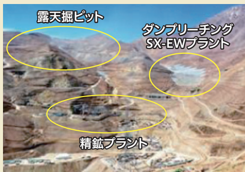
カセロネス鉱山全景
